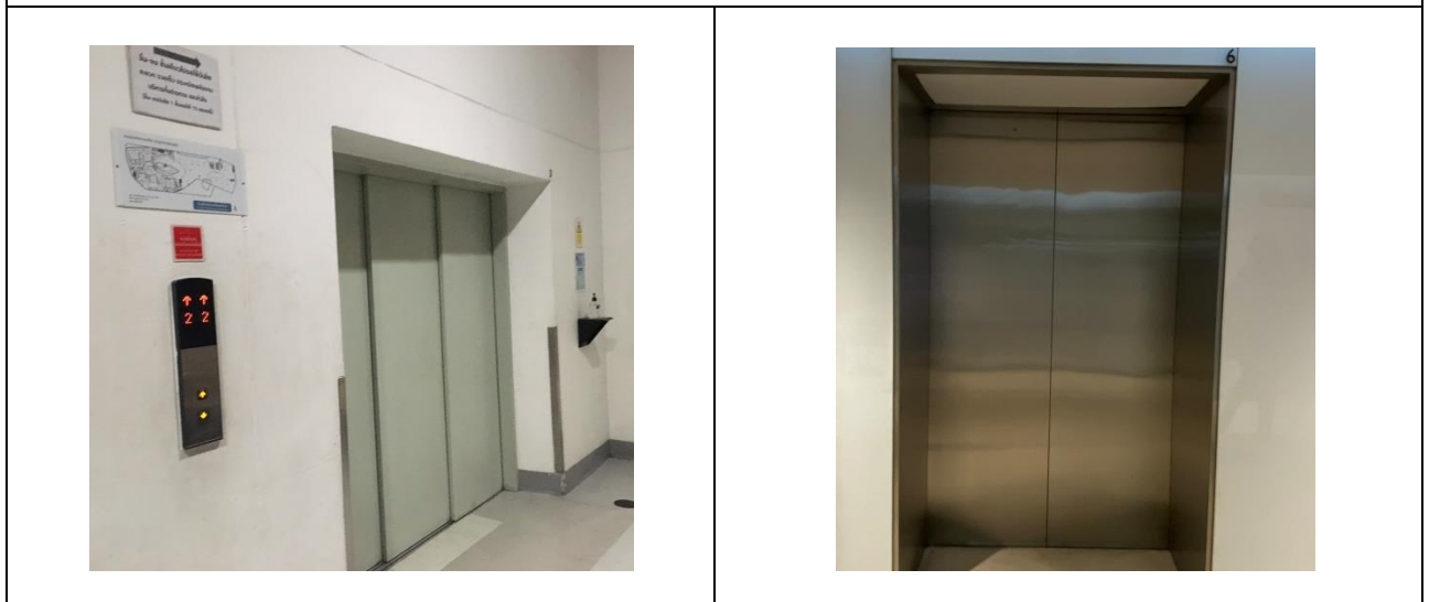
รูปที่ 2.28 ลิฟต์ดับเพลิง
