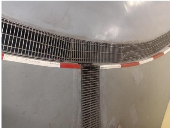
รูปที่ 2.47 ตะแกรงครอบท่อระบายน้ำ
