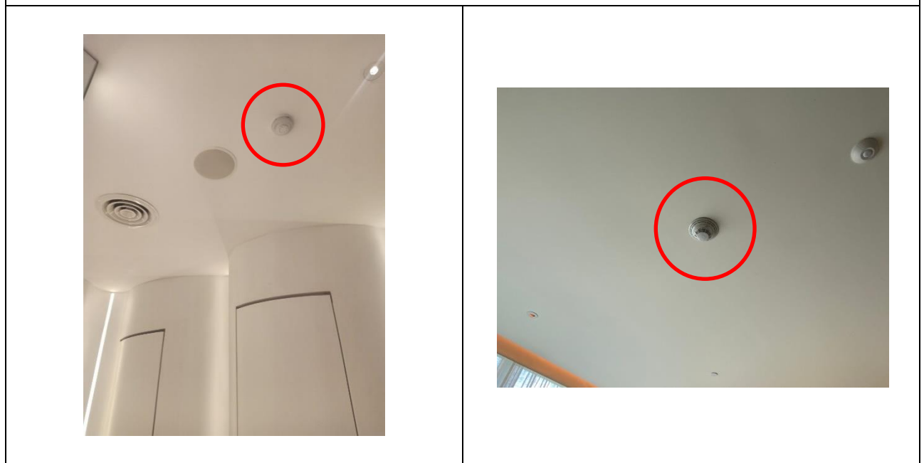
รูปที่ 2.25 เครื่องตรวจจับความร้อน
