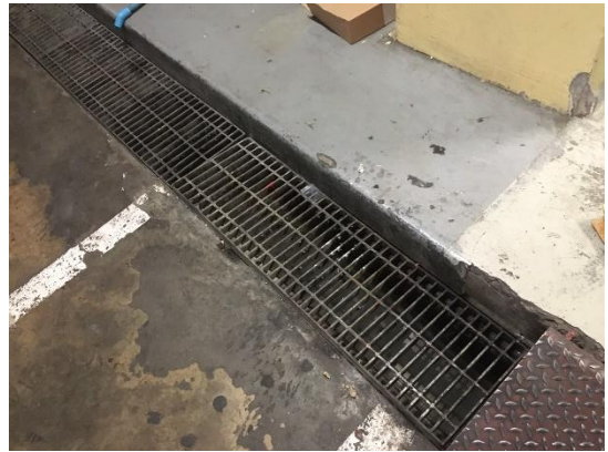
รูปที่ 2.47 ตะแกรงครอบท่อระบายน้ำ
